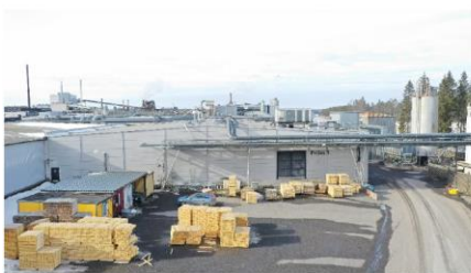
Uuden ja vanhan osan liittymä kaakkoispuolella
