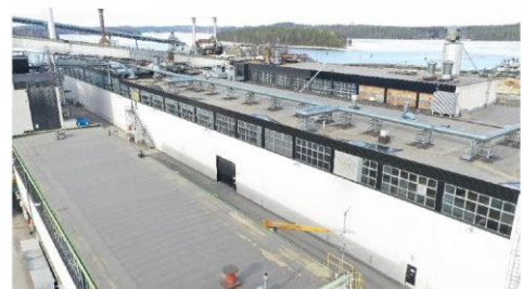
Vanhan osan julkisivu
