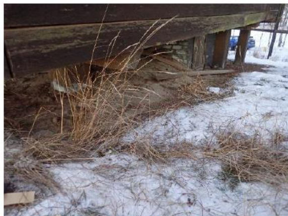
Kuva 2. Myös rakennuksen eteläpäädyssä on paikoin kasvillisuutta lähellä rakennusta. Maanpinta viettää kohti järveä.
