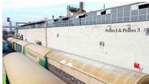
Vanhan osan julkisivu yleisilme
