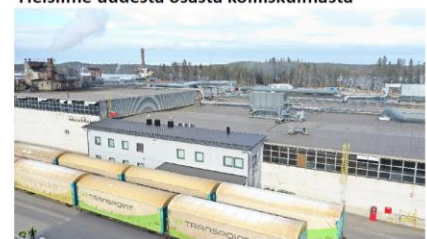
Uuden ja vanhan osan liittymä lounaispuolella
