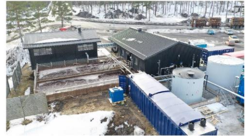
13. Jäteveden puhdistamo (oikeanpuoleinen rakennus)
